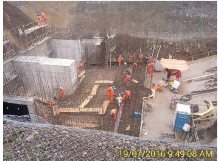
Vista de la Enfierradura del Radier de la 3ª Etapa de Hormigonado.
