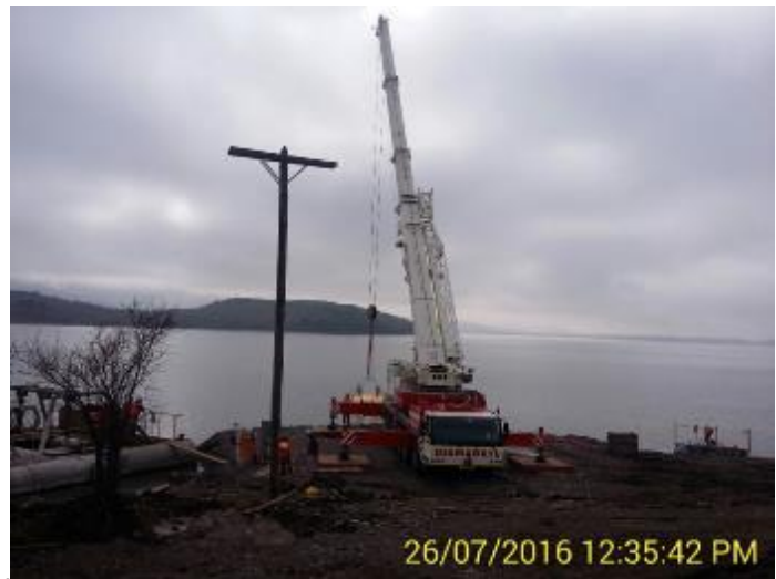
Traslado y Hundimiento controlado del Tapón Toriesférico con la Grúa Liebherr de 250 Ton.
