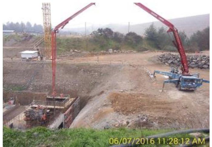
Hormigón muros N° 1, 2, 3 y 7 de la 1ª Etapa de Hormigonado.
