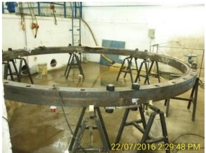
Armado y nivelación de las dos Bridas de la Tubería de la Aducción
